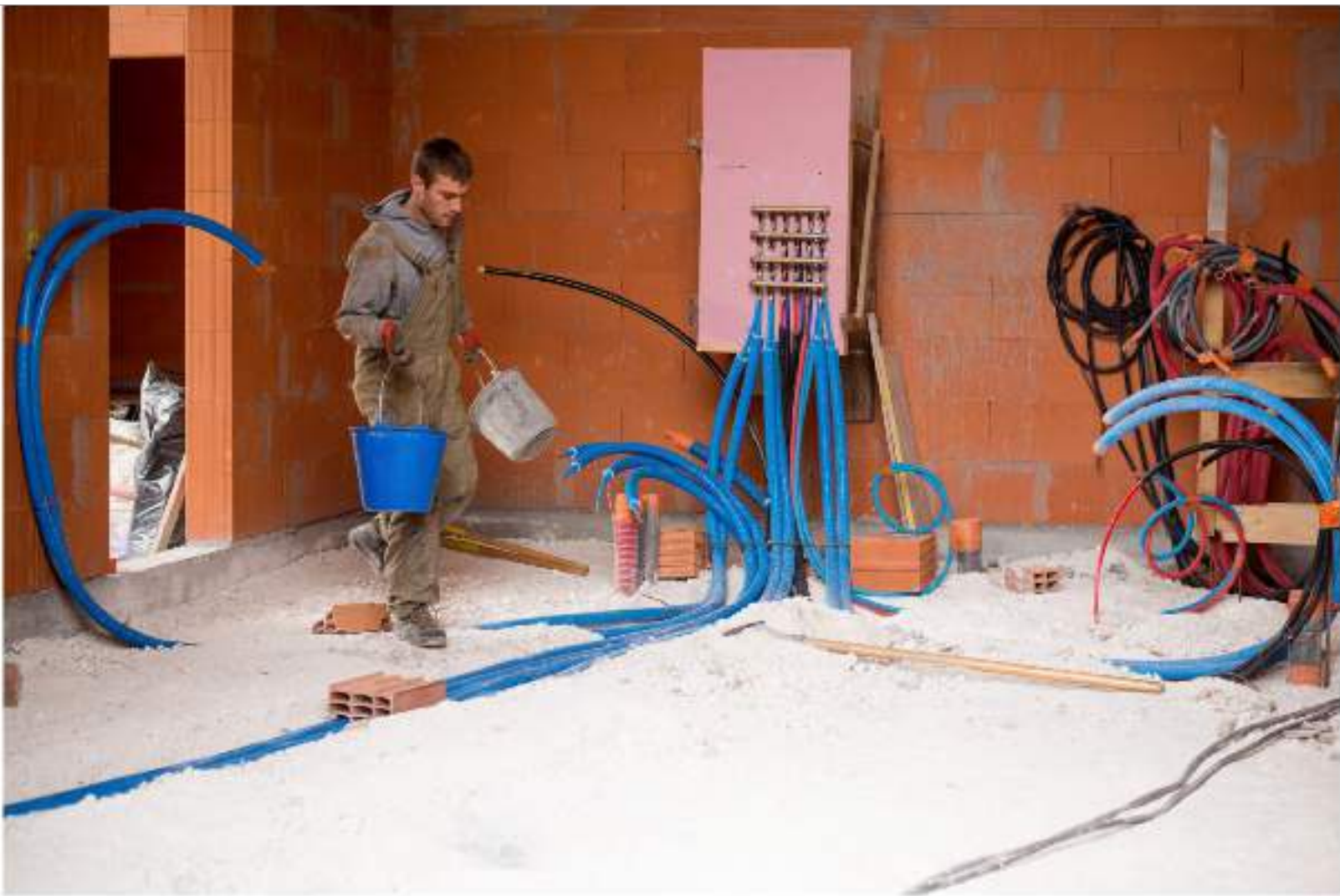
Chantier de bermuda à Sergy. Photo: Guillaume Robert, 2020
